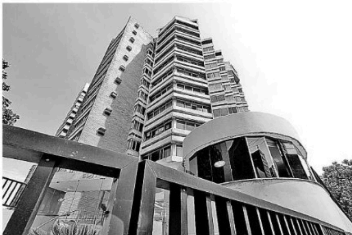
PORTARIA Para assegurar a segurança do condomínio é necessário equipamentos e protocolos
